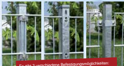
Es gibt 3 verschiedene Befestigungsmöglichkeiten: Klemhalter, Flacheisenschiene oder Klemmschellen
